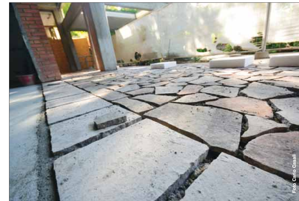
Uno scorcio del cantiere
